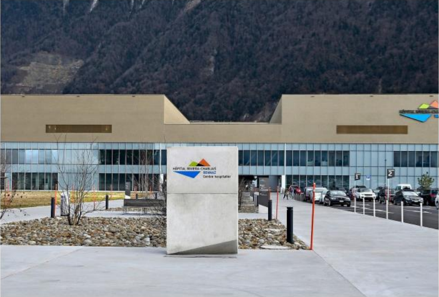
Le surcoût de la construction de l'hôpital de Rennaz s'élève à plusieurs dizaines de millions de francs. CHANTAL DERVEY
